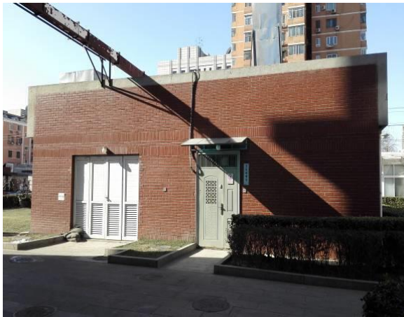
污水处理站外部
