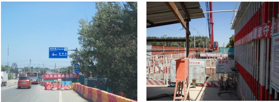
图 6.2-3 定福庄再生水厂配套管线施工现场照片
