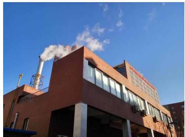
燃气锅炉房外景
