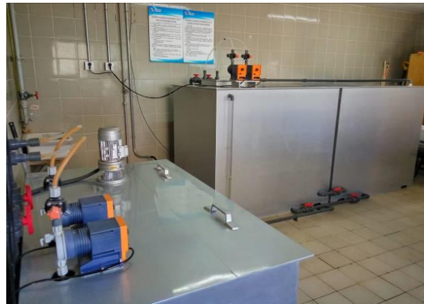
污水处理站内部
