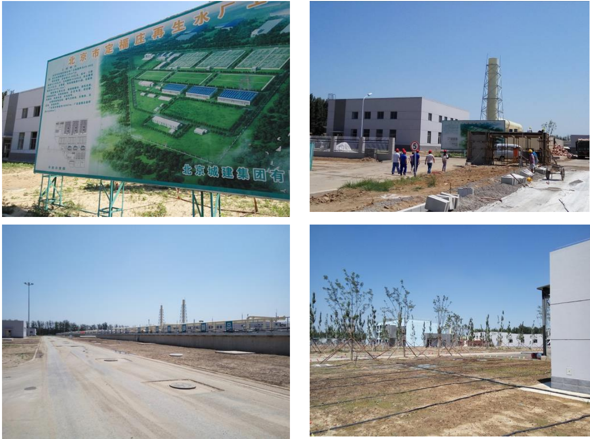
图 6.2-2 定福庄再生水厂施工进度现场照片
