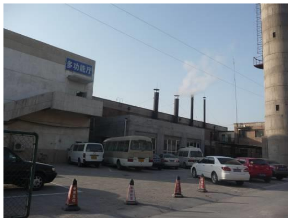
燃气锅炉房外景
